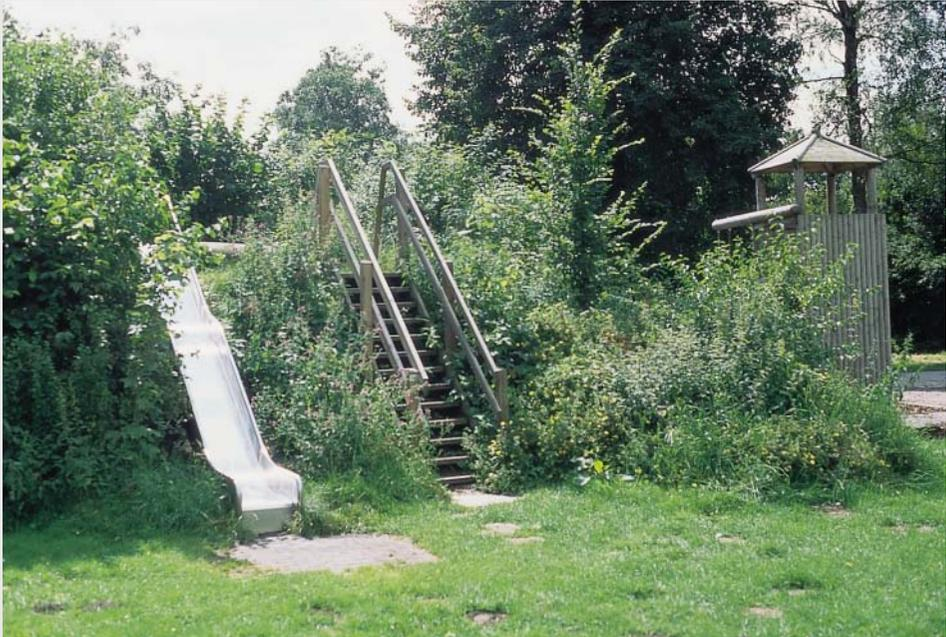
Ausreichend befestigte Rutsche (DIN EN 1176), ungeeigneter Auslaufbereich
