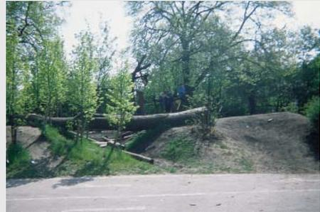
Stoßdämpfender Untergrund unter „Brücke“ mangelhaft (Baumstämme)
